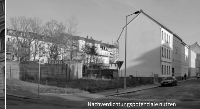
Baulückenschluss durch Neubau
