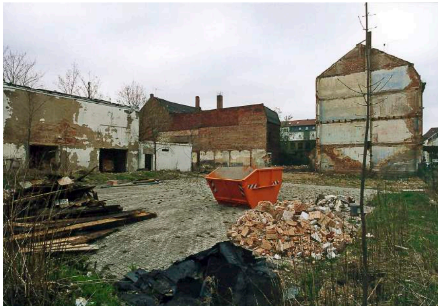
Blick in den Eingangsbereich der Nachbarschaftsgärten im Herbst 2004. Links erkennt man das damals noch einsturzgefährdete zukünftige RAD-Haus mit eingemauertem Elektroauto.
