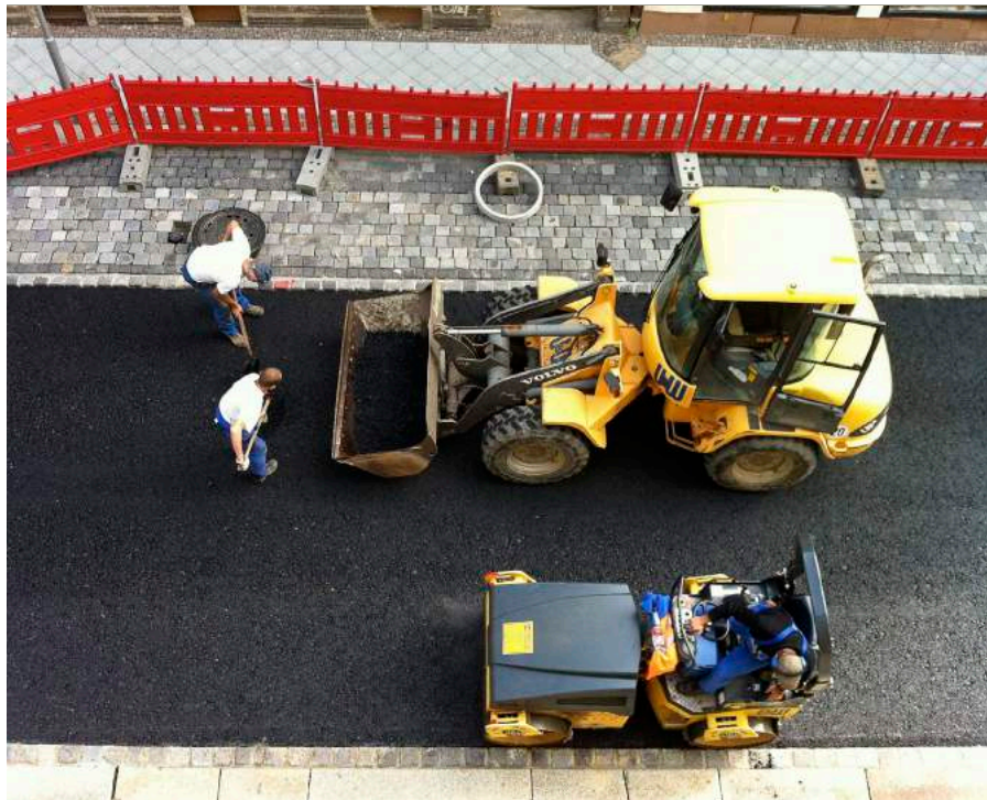
Die Josephstraße wurde 2011 mit Rücksicht auf den Bau des BuchKindergartens in mehreren Abschnitten saniert.
