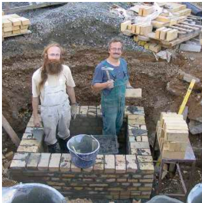
Rainer Müller und Wilfried Grünert beim Mauern des Abwasserschachts 2004.
