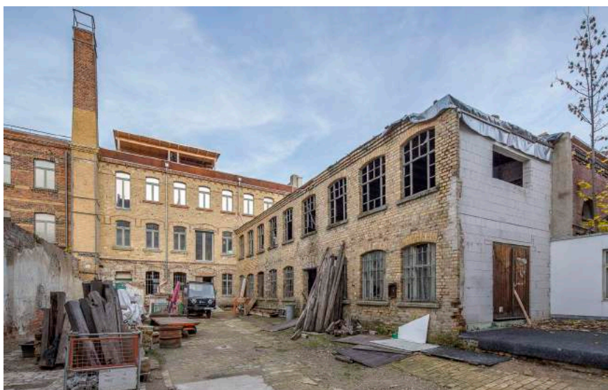
Die Sanierung des ehemaligen Industriebauwerks geht langsam aber stetig voran.
